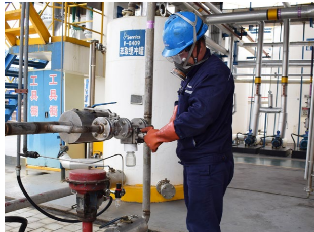
山东华鸿在工艺管道或罐体开口位置安装法兰式取样阀，减少取样员工作业风险
