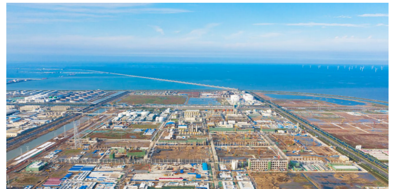
中化连云港循环经济产业园
